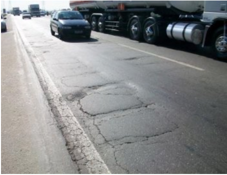
Figura 1. Muestra del fallo presente en la vía
