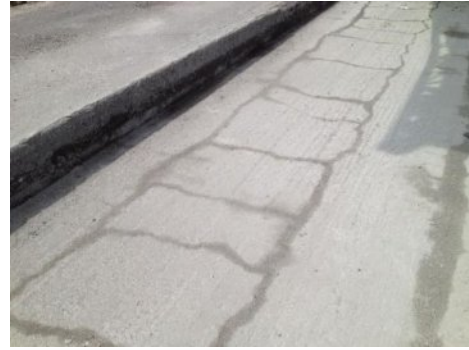
Figura 2. Muestra del fallo de la BGTC a 30cm de profundidad posterior al fresado
